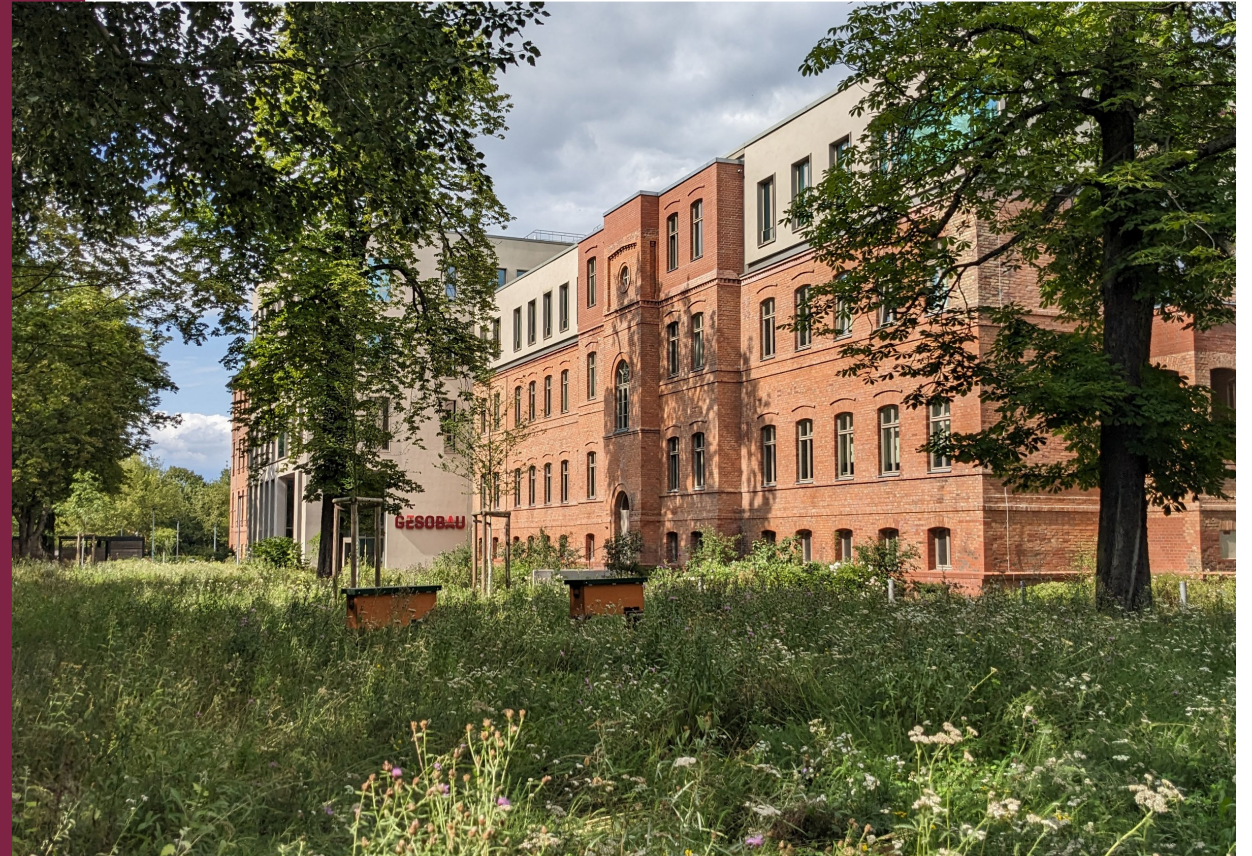
© GESOBAU AG: GESOBAU-Zentrale im Stiftsweg
