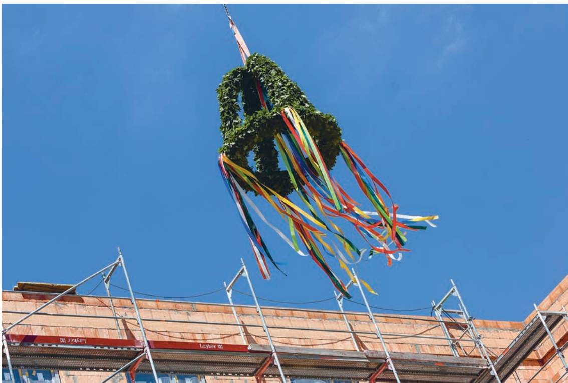
In schöner alter Tradition wird beim Richtfest allen Beteiligten Dank gesagt
