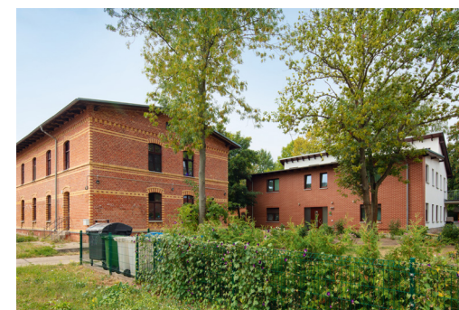
Das Bauvorhaben am Stadtgut Hellersdorf wird durch einen aktiven und erfolgreichen Partizipationsprozess begleitet.
