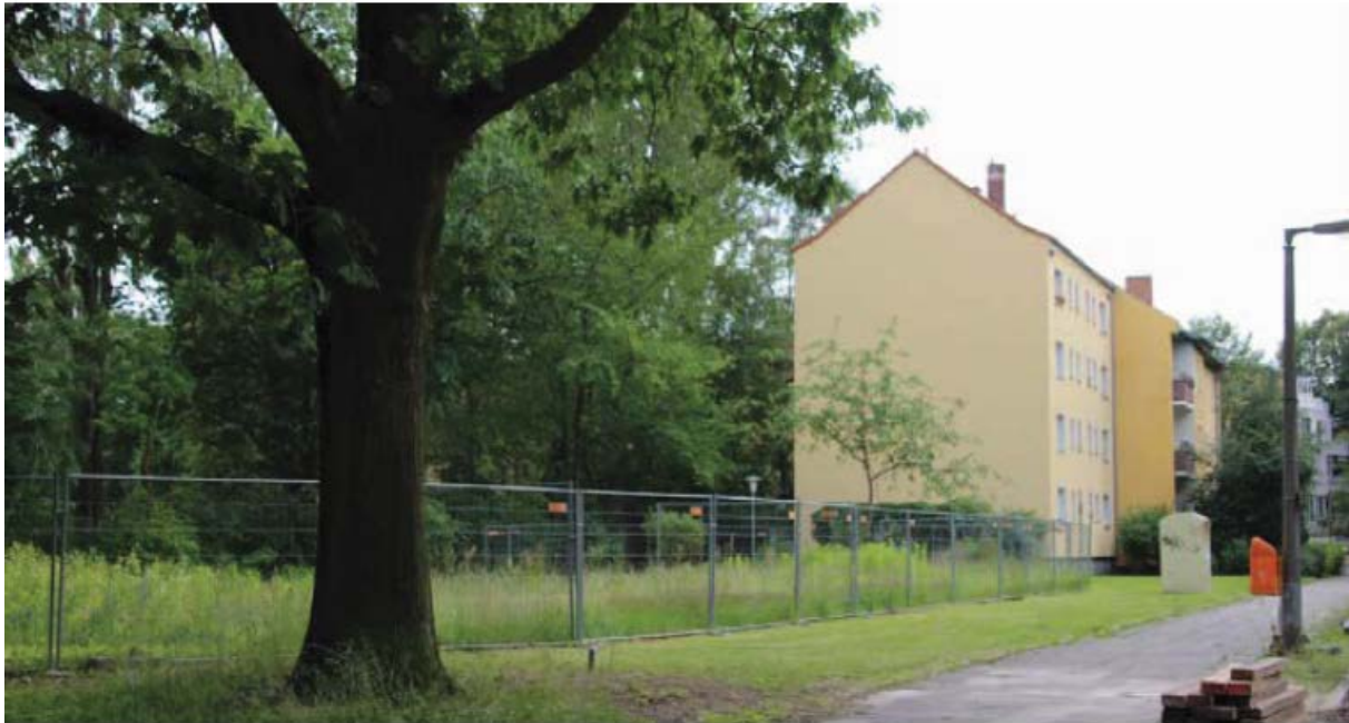
Straßenansicht Grundstück Am Schloßpark 30 / 32
