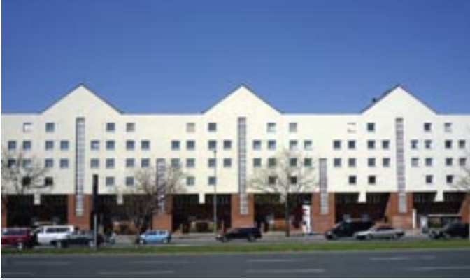
Auch die Wohnanlage am Lützowplatz (1982/83) mit der markanten Giebelfassade gehört zu den bekannteren Werken Ungers
