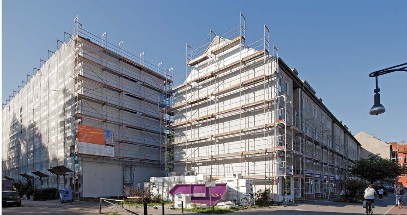
Modernisierungsarbeiten Breite Straße in Pankow
